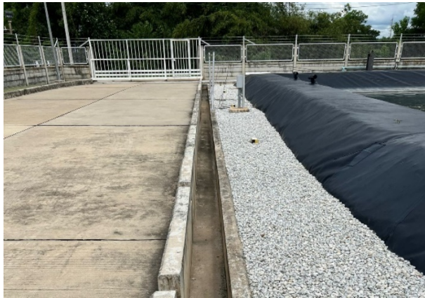
รูปที่ 2-11.2 รางระบายน้ำฝนที่ปนเปื้อน
