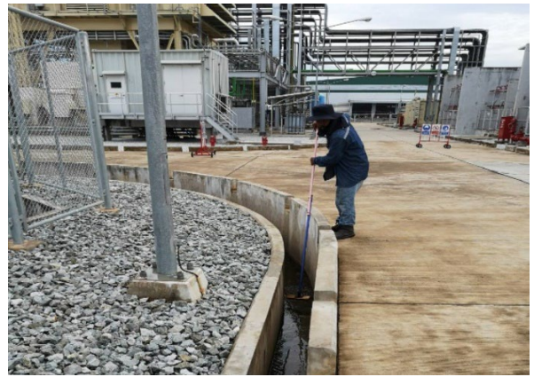
รูปที่ 2-11.3 การทำความสะอาดรางระบายน้ำ
