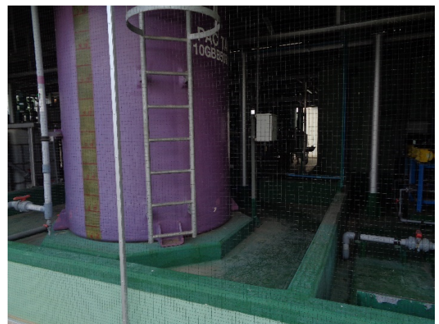
รูปที่ 2-14.14 Berm สำหรับป้องกันสารเคมีรั่วไหล
