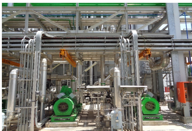
รูปที่ 2-15.4 ป้อนเติม HRSG สำรอง
